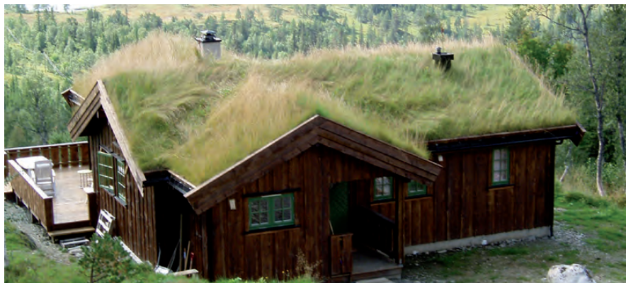
Døme på ulike typar grøne tak og fasadar. Øvst (bilete nr. 6): Eit døme på løkk over konstruksjon Over (bilete nr. 7): Eit typisk døme på ekstensivt tak der det må passast på vedlikehaldet slik at det ikkje legg seg opp jordlag og blir intensivt er torvtaket Under (bilete nr. 8): Takhagar kan vera nydelige erstattningar for landskapsområde på bakken. Her Kaiser Center, Oakland-California.
