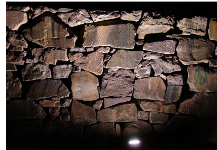
Vasking av brofundament
