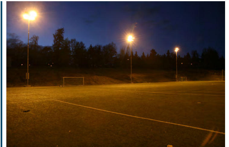
Dei tri mastene på eine sida, med 4 armatur kvar.
